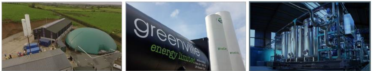
Figur 8: Opsætning af Cryo Pur løsning i Greenville, UK
