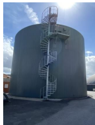
Figur 3: Eksempel på reaktortank fra Energi Vegger, Nibe.
