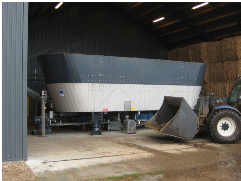
Figur 5. Forbehandlingsudstyr ved anvendelse af en stor andel faste biomasser
