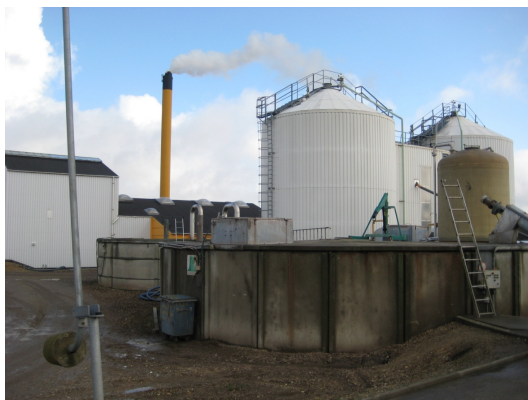
Figur 4. Filskov biogasanlæg med fortanke, reaktortanke og aflæssehal
