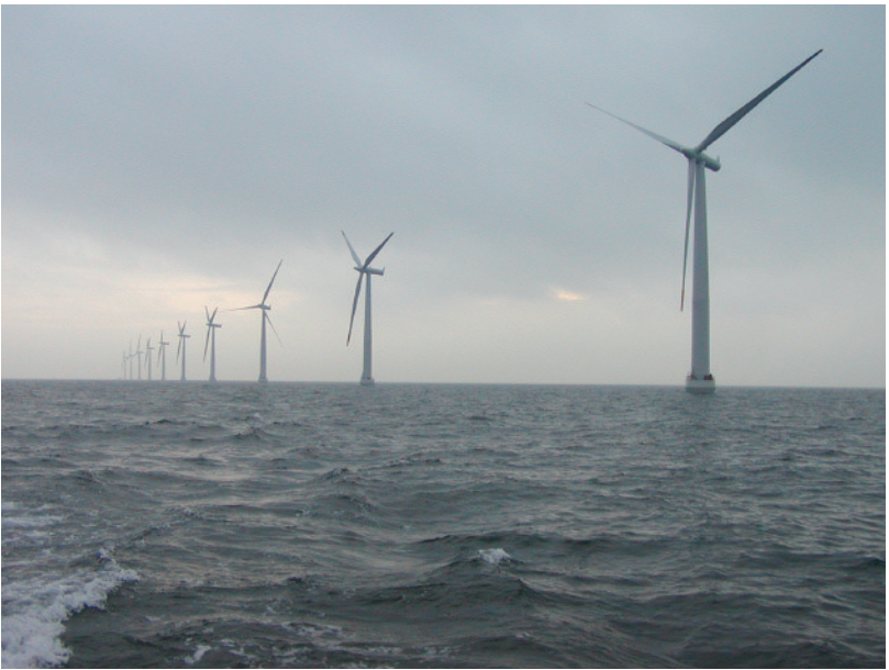
2,3 MW havvindmøller syd for Samsø, etableret af Samsø Havvind A/S i 2002
