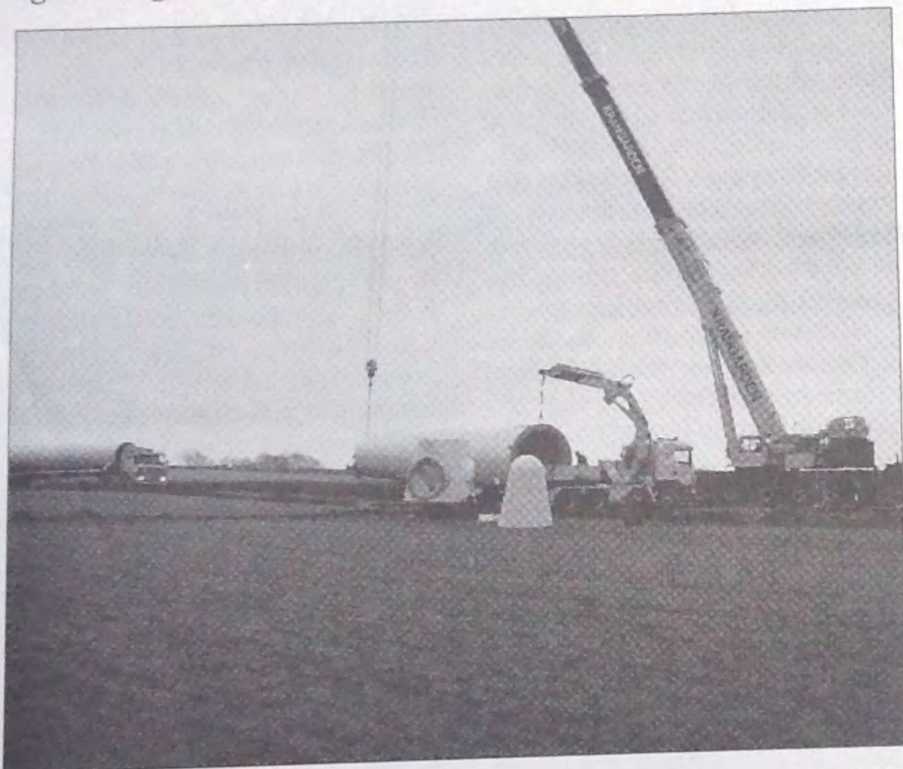
Nederste tårnsektion løftes af lastbilen
