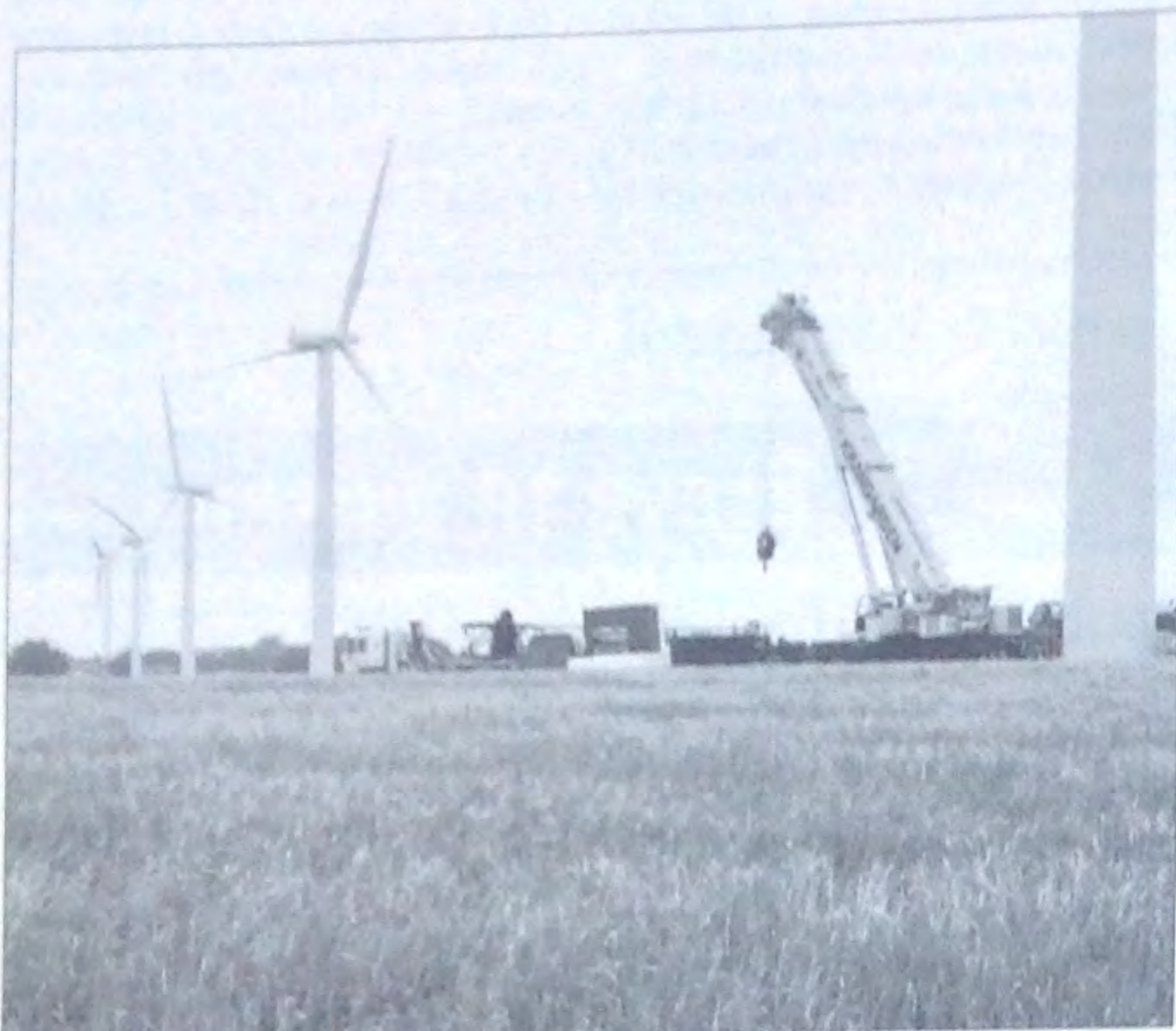
Torsdag over middag pakkede mandskabet fra "Krangården" den store mobilkran sammen for sidste gang på Samsø. Selve mobilkranen, som med vægklodser til kontravægte vejer 90 tons fordelt på otte aksler, har følgeskab af yderligere to lastbiler. Endnu en otteakslet lastbil kører med kranarmen, og en "lille" syvakslet lastbil kører med de tunge kontravægte. På billedet ses lastbilerne sammen med de fem Brundby-møller.
