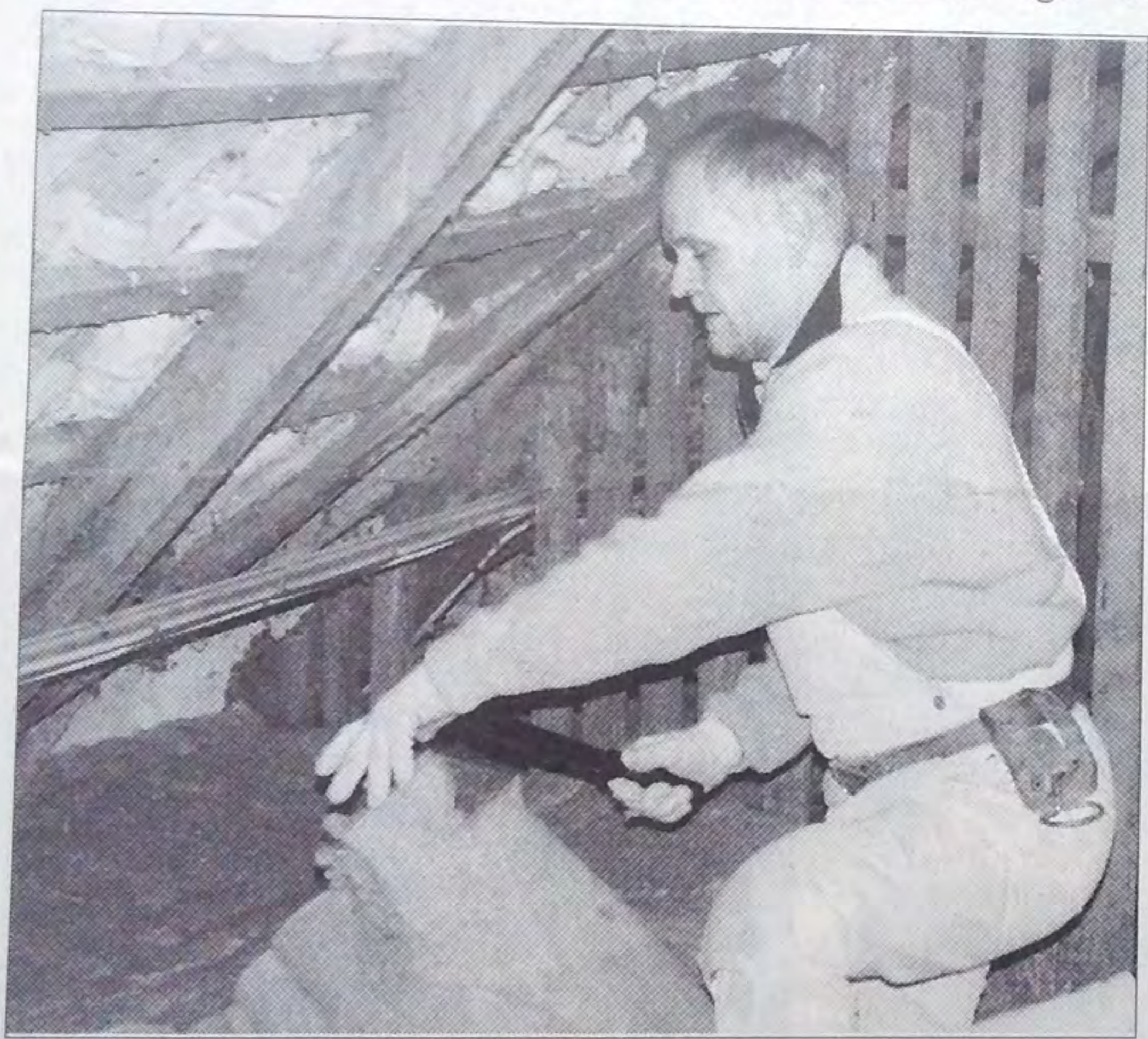
Tømrmester Karl Erik Fast i gang med isolering med hørmåtter. Arbejdet kan udføres uden brug af maske, da hørren ikke støver som andre isoleringsmidler.
