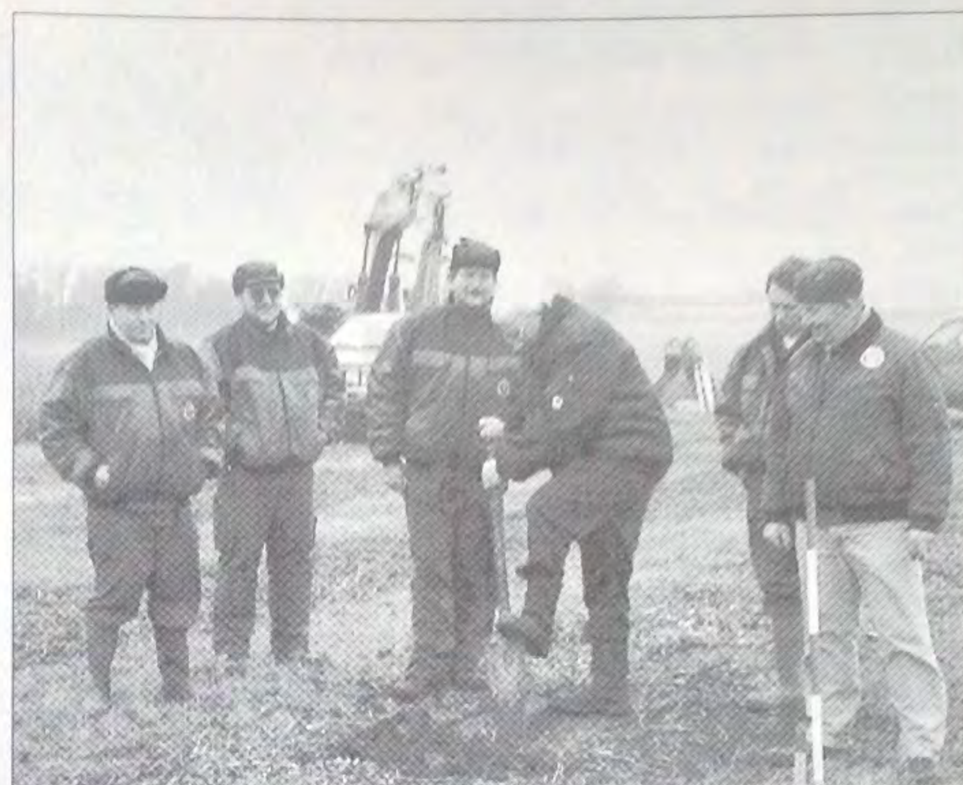
Bent Schaloffsky tager første spadestik til VE-Ø projektets vindmøller
