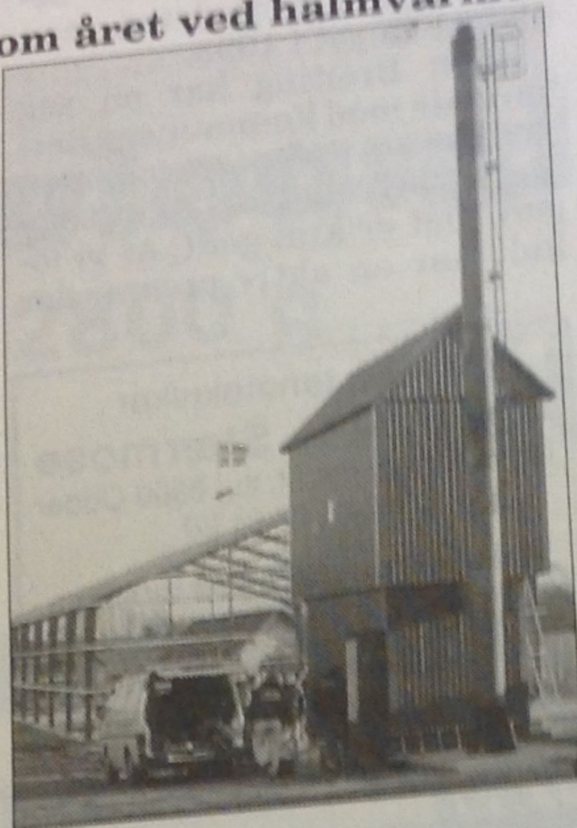
Selve halmfyret blev rejst natten til onsdag, og kranaen og flagehallen beregnet til halmlager blev rejst inden håndværkere, elever og lærere på Samsø Efterskole kunne erklære det vedvarende biomasse energianlæg for cirka halvejs klar til brug.
