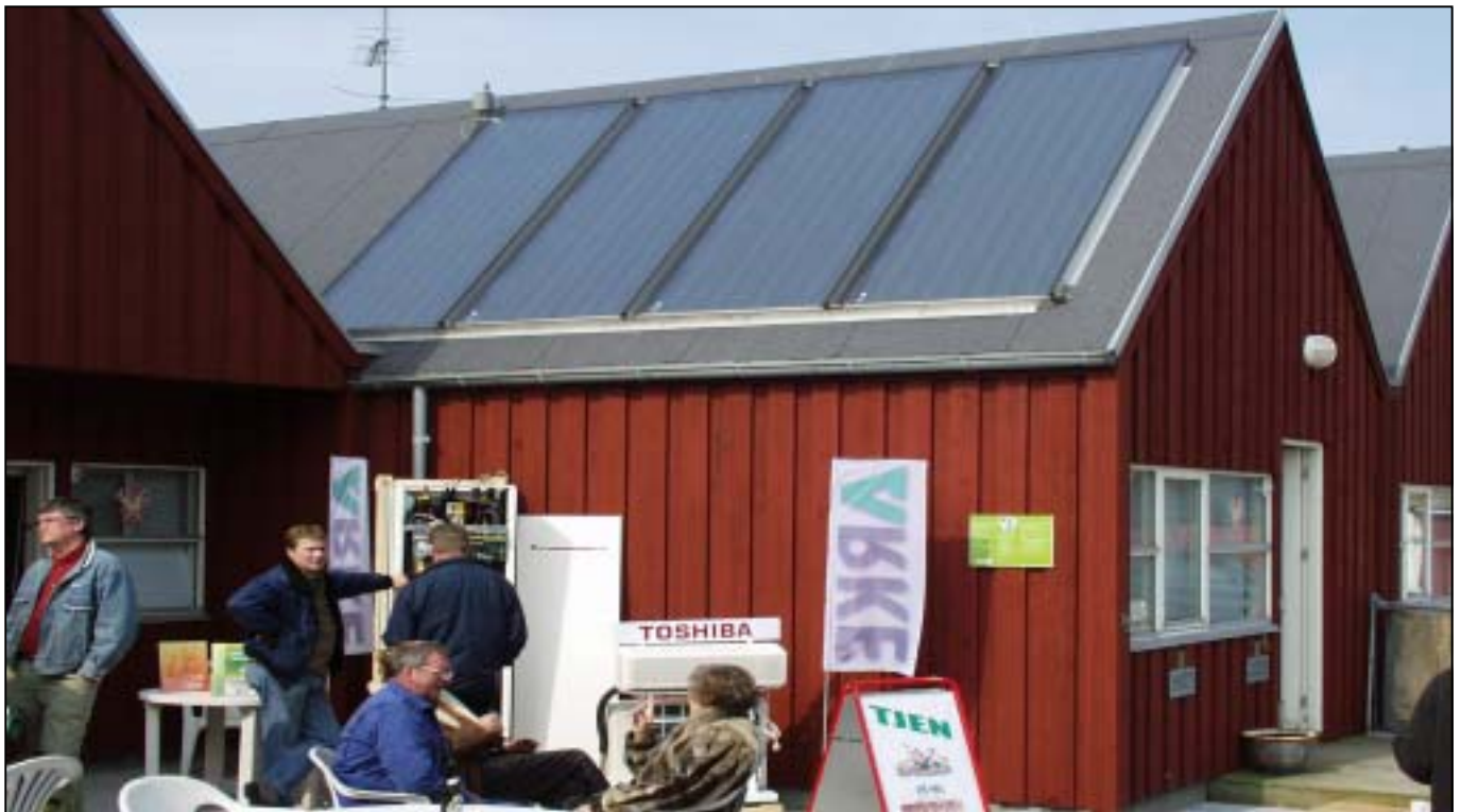
Solvarmeanlæg i Mårup Havn
